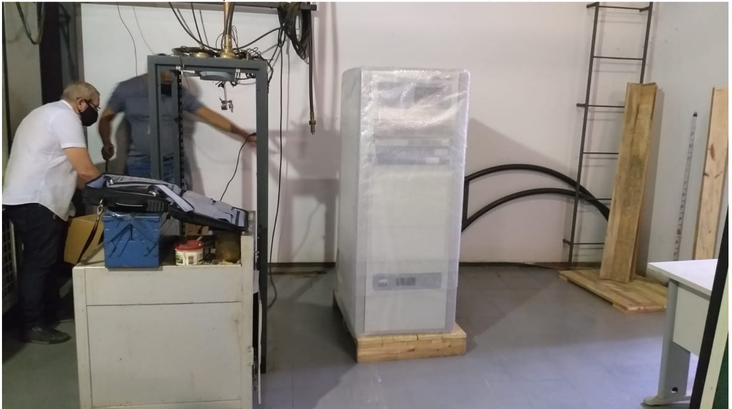
Foto 3: Processo de instalação do transmissor no radiador A2
