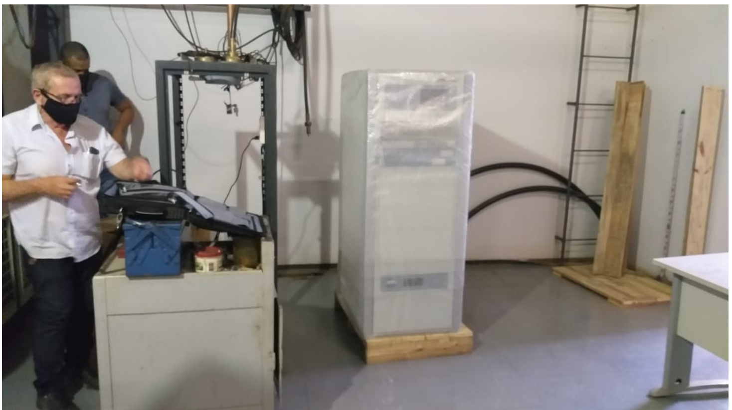
Foto 4: Continuidade da instalação.
