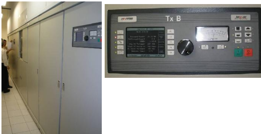
Figura 3 – Transmissor Harris 3DX-50 (esq). Detalhe do painel de controle (dir)
