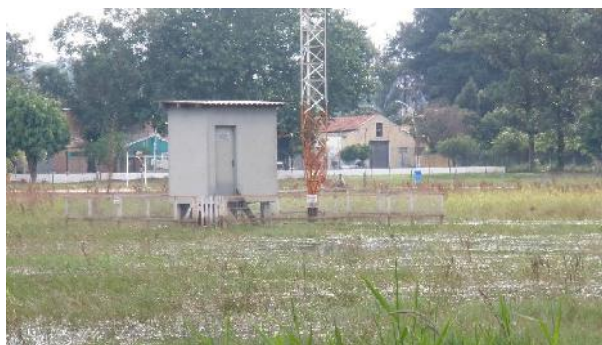
Figura 4 – Base da torre e casa de sintonia
